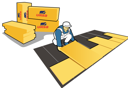
2 Układanie warstwy termoizolacji z płyt URSA XPS
