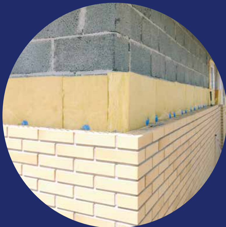
Zdjęcie 4 – Mur trójwarstwowy ze szczeliną wentylacyjną
