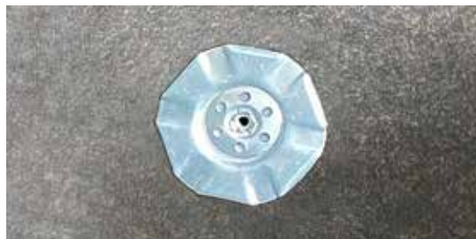
Zdjęcie 3 • Mocowanie płyty URSA VENTO 34 łącznikiem typu DMH-DMT
