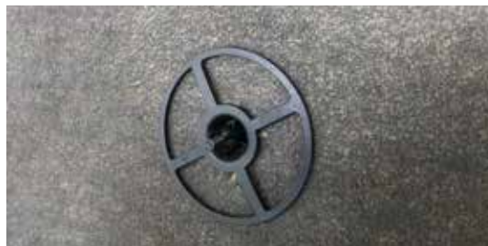
Zdjęcie 2 • Mocowanie płyty URSA VENTO 34 łącznikiem typu DH
