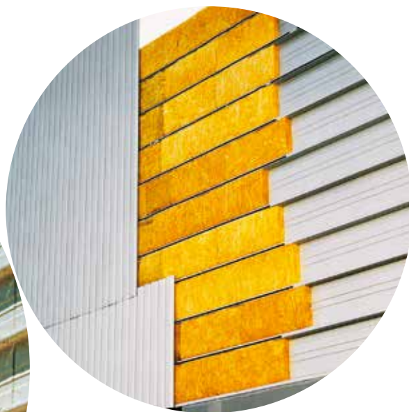
Zdjęcie 5 • Montaż płyt izolacyjnych URSA przy izolacji hal stalowych
